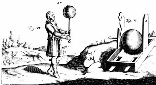
Zdjęcie III: Urządzenie elektryzujące (lub wytwarzające elektryczność) Guericke (z prawej), Guericke z kulą z siarki (po lewej) z [1], str.166
